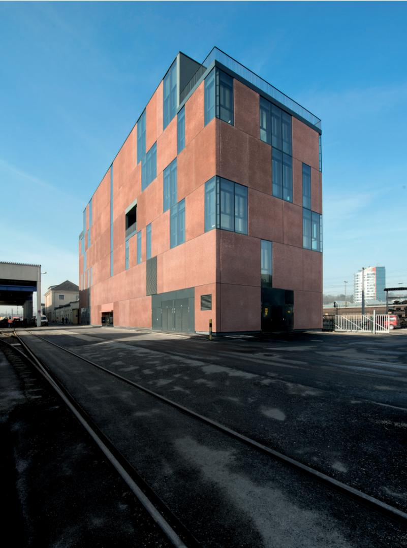
energieautarkes Gebäude konzipiert. Die energetische Autarkie wird sich ab dem technischen Vollbetrieb, sprich bei vollständiger Besiedelung des Gebäudes, einstellen. Als primäre Wärmequelle wird im Vollbetrieb für das gesamte Gebäude die Abwärme aus den Technik- und Serverräumen mittels Wärmeauskopplung genützt, welche im Sommer an die Umgebung abgegeben wird und im Winter das Objekt wärmetechnisch versorgt.
