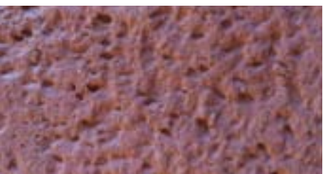
durchgefärbte Stahlbetonfassade
