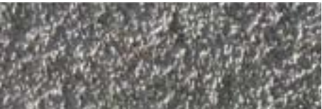
durchgefärbter Kratzputz Stiegenhaus
